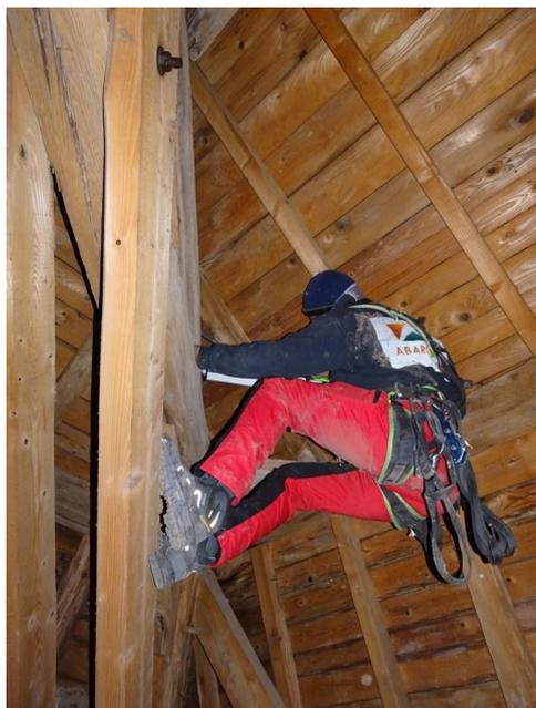
Sonder les poutres avec un sapromètre® permet d'apprécier leur état sanitaire.
