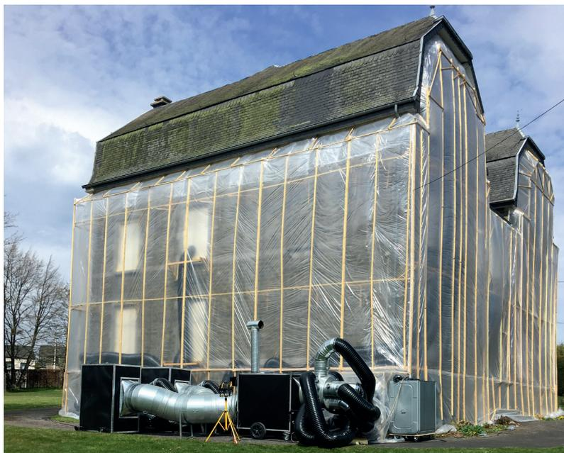
Le traitement par air chaud nécessite d'emballer l'immeuble avant la mise en chauffe.
